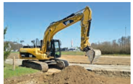
Baubeginn mit dem Bagger.
