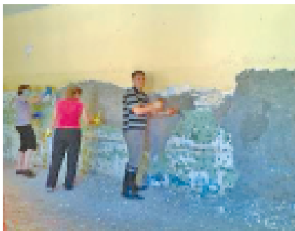
Lehrpersonen beim Verputzen der Wände.
