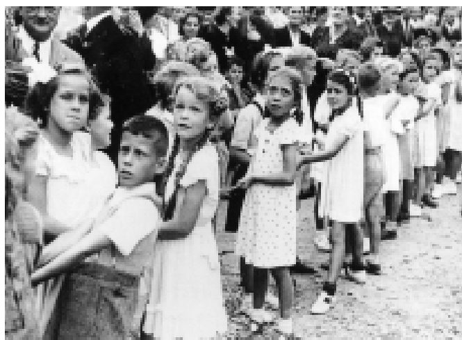
Glockenaufzug bei der Kirche Buchs.
