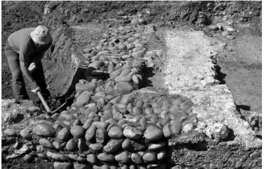
Quermauer: Pollensteinfundament ohne Mörtel.
