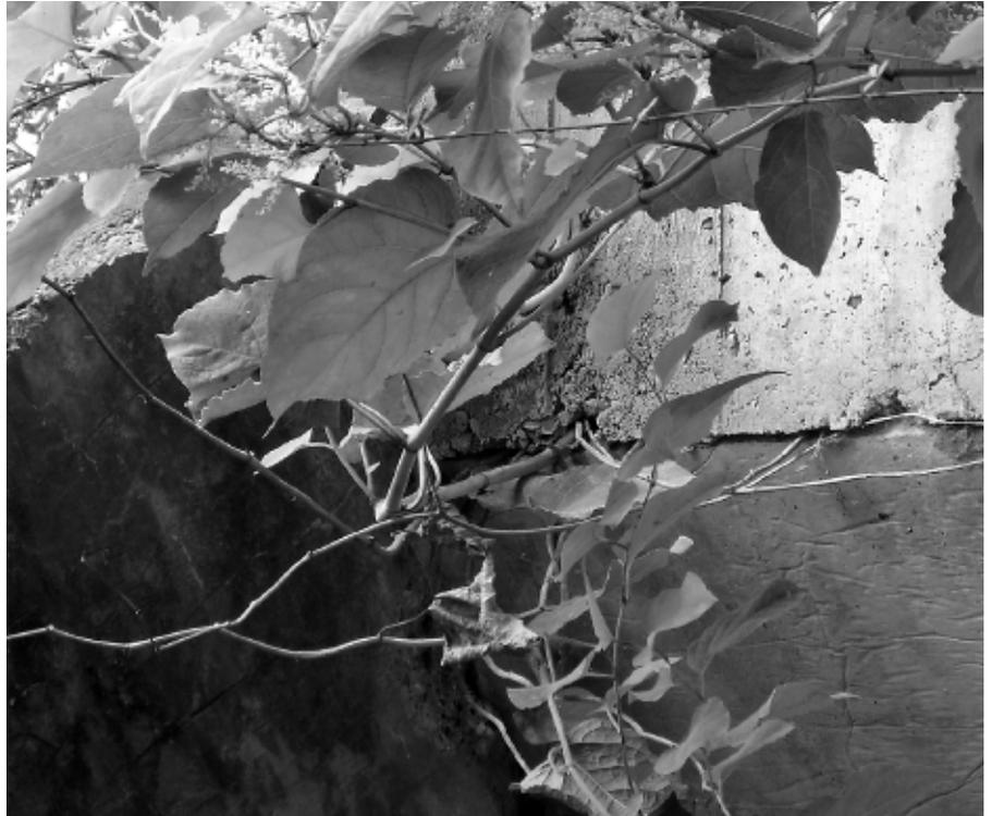
*Infrastruktur-Schäden durch Neophyten: Ein Japanknöterich wächst durch eine Mauer (© Baudirektion Kanton Zürich).*
