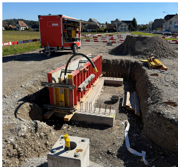
Fundament Buswartehalle, Teilprojekt 3
