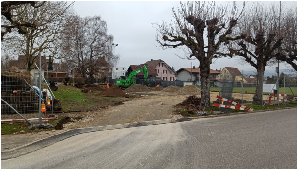
Baustelle neuer Hartplatz Schulanlage Gysimatte
