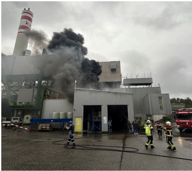
Einsatz in der KVA Buchs
