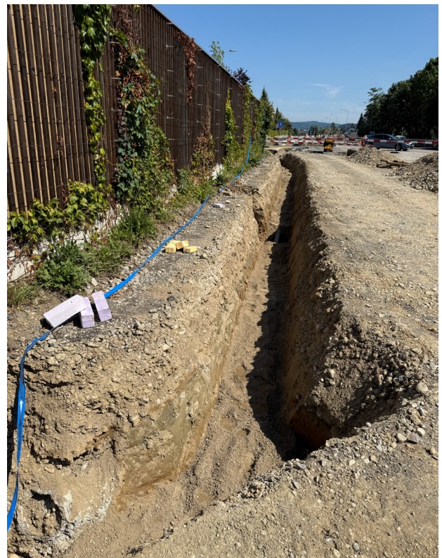
Wasserleitungsgraben an der Tramstrasse entlang der Lärmschutzwand
