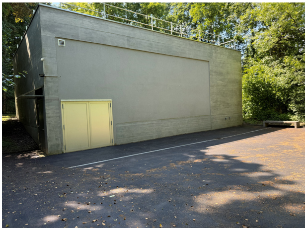
Gebäude Grundwasserpumpwerk Kirchmatten mit saniertem Vorplatz
