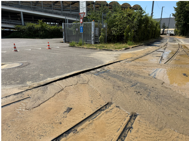
Wasserleitungsbruch Bresteneggstrasse 1. Juli 2025
