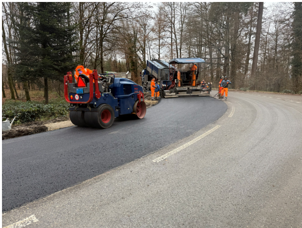
Im Lostorf, Strassenverbreiterung und Belagsersatz
