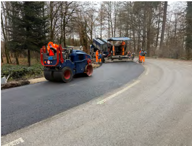
Im Lostorf, Strassenverbreiterung und Belagsersatz
