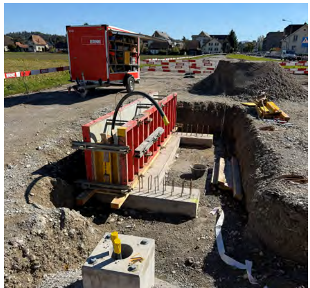
Fundament Buswartehalle, Teilprojekt 3
