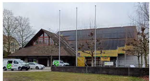
neu montierte PV-Module auf dem Dach des Gemeindesaals
