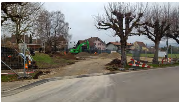
Baustelle neuer Hartplatz Schulanlage Gysimatte
