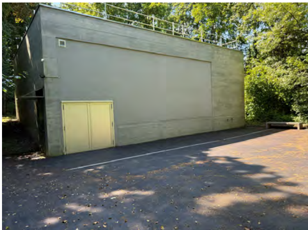
Gebäude Grundwasserpumpwerk Kirchmatten mit saniertem Vorplatz
