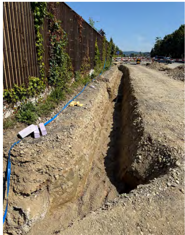
Wasserleitungsgraben an der Tramstrasse entlang der Lärmschutzwand
