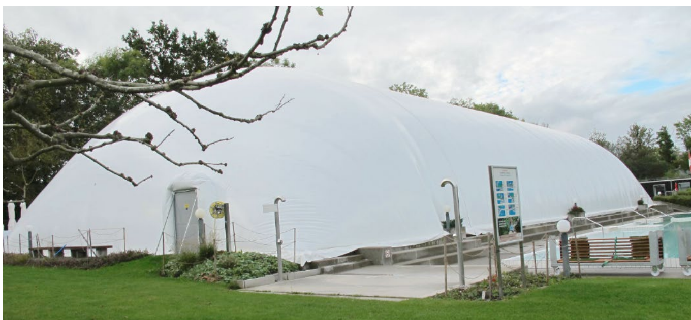
So präsentiert sich die Traglufthalle im Schwimmbad Suhr-Buchs-Gränichen.
