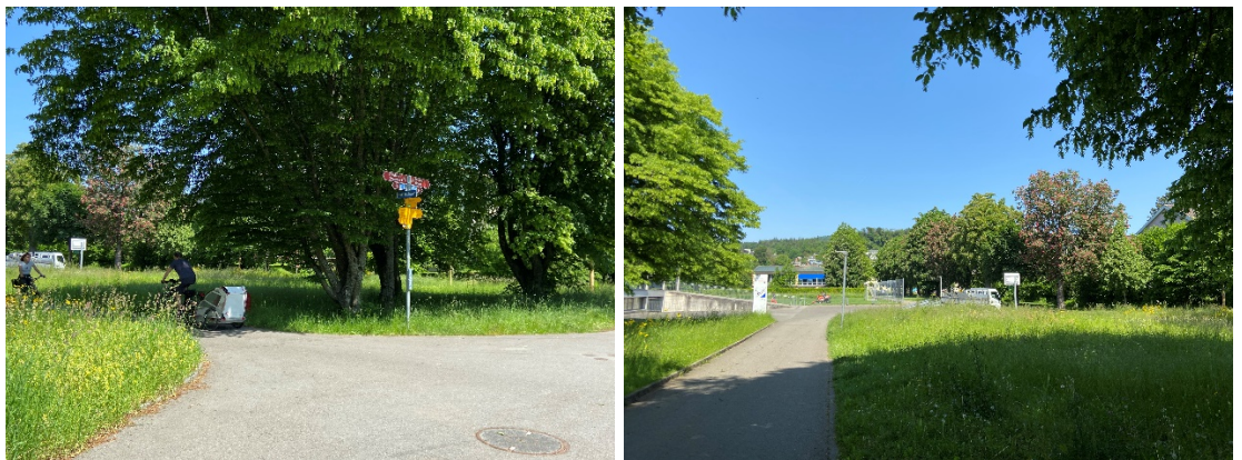
Abb. 28 Bestehender Veloweg, Aarestrasse Rombachweg / Schulareal, Fotos: suisseplan Ing. AG
