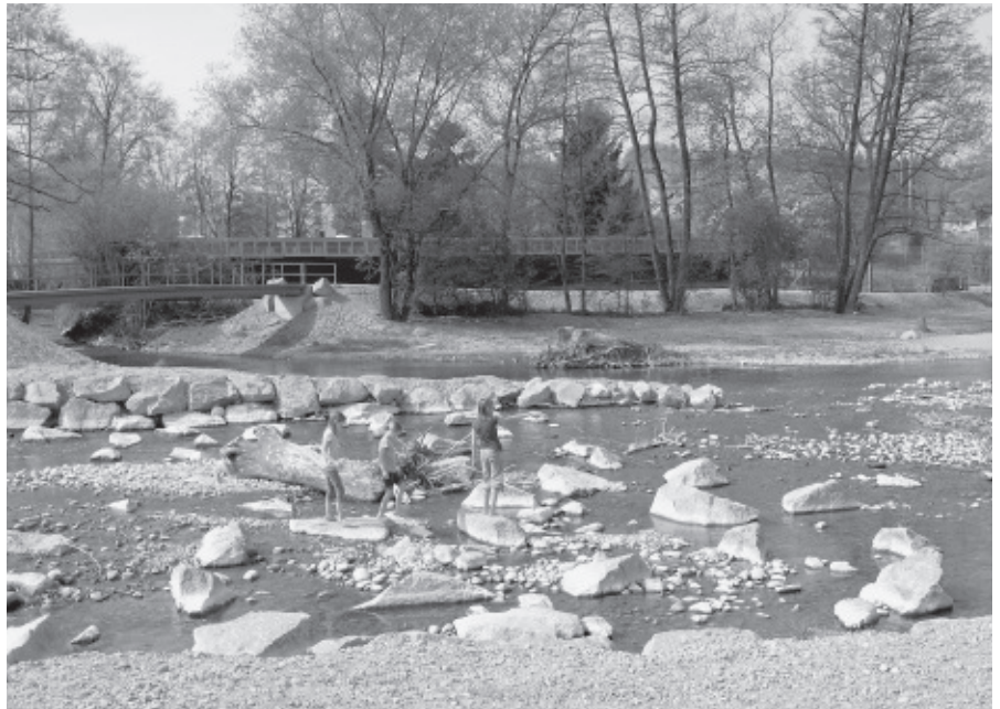
Suhre und Wyna haben ein neues Bachbett mit viel Platz erhalten.
