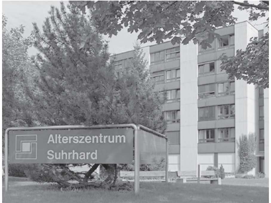
Das Alterszentrum Suhrhard bedarf einer Sanierung und Erweiterung.
