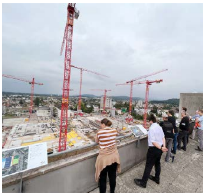
Besichtigung der KSA-Baustelle.
