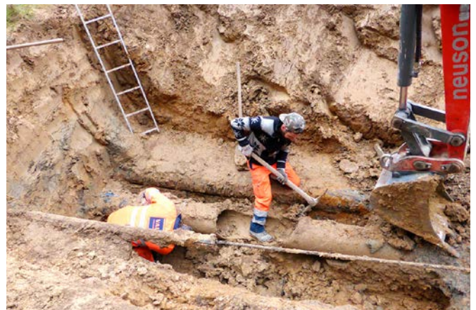
Ein Rohrleitungsbruch wird repariert.
